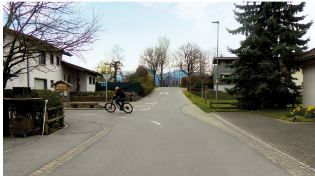
Abb 24 Beispiel einer Mittelmarkierung in einer Kurvensituation und einer gepflasterten Einengung
