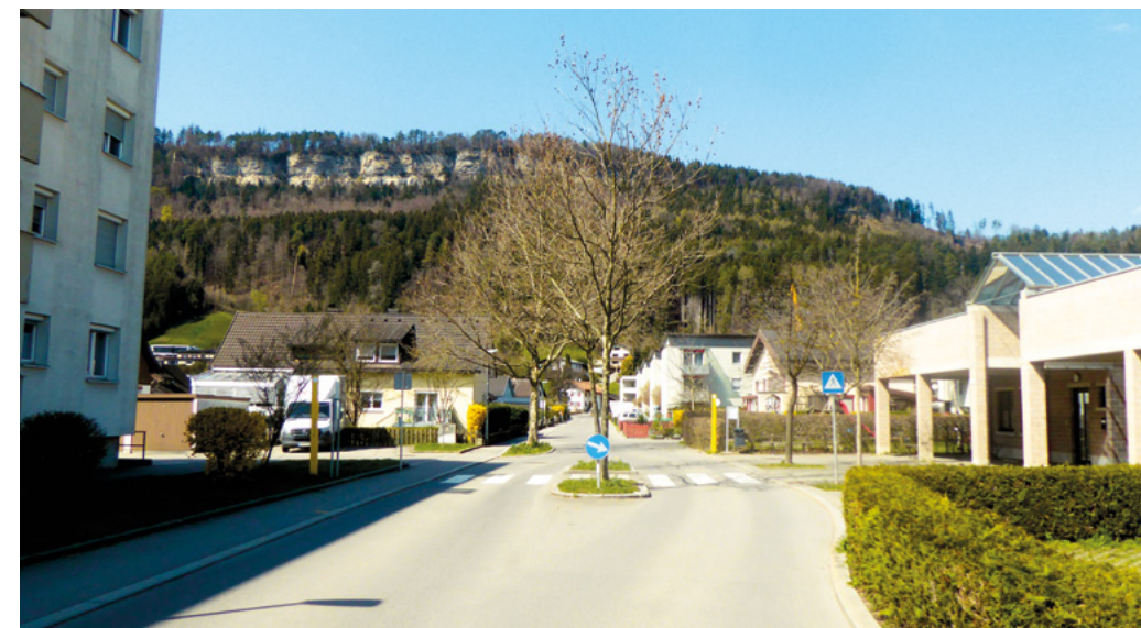
Abb 19 Beispiel einer Verkehrsinsel mit Schutzweg als Einengung
